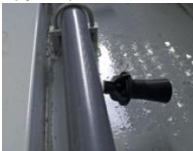
Система трубопровода очистителя поддона **усиливает циркуляцию и перемешивание воды в бассейне** и разработана для использования в комбинации с [системой фильтрации](#). Эта система:
