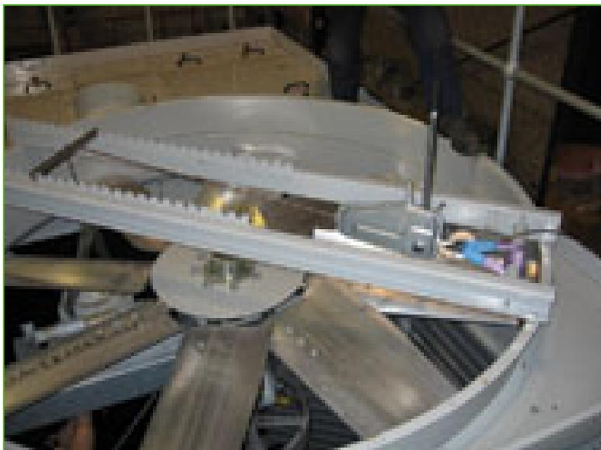
Установка легкой системы демонтажа механического оборудования поможет вам **демонтировать или монтировать моторы вентиляторов или редукторы.**
