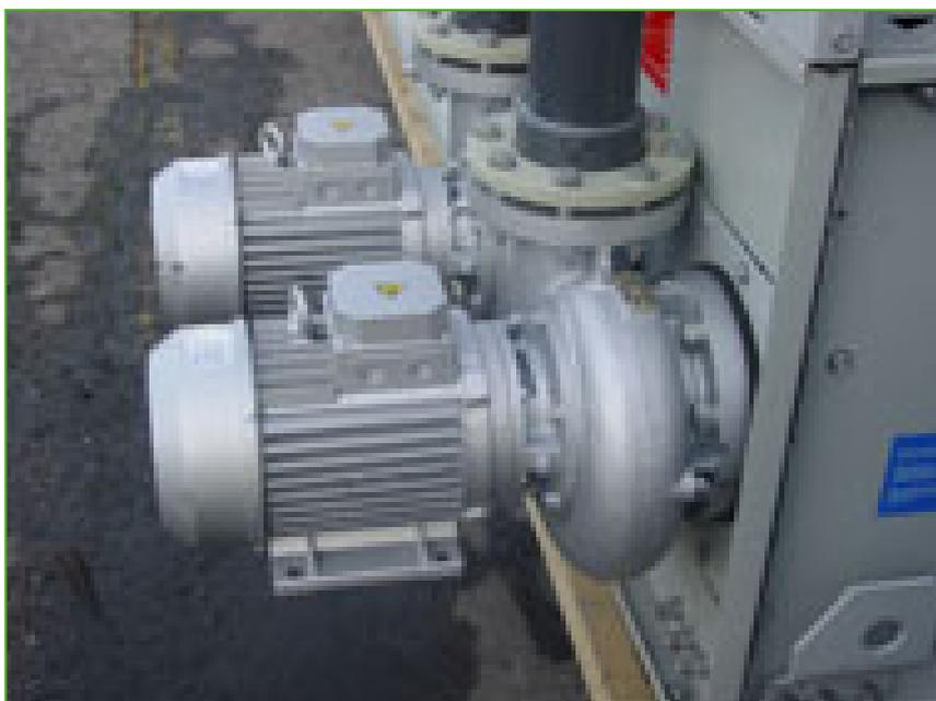
Установка резервного насоса **гарантирует надежную круглогодичную работу** – он принимает нагрузку в случае отказа основного мотора.
