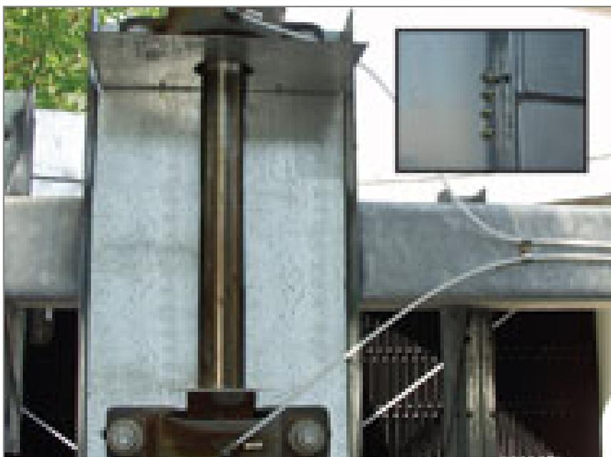
Des lignes de lubrification prolongées équipées de graisseurs peuvent être mises en oeuvre pour lubrifier les paliers d'arbre de ventilateur. Les graisseurs sont situés à l'intérieur du plenum, à côté de la porte d'accès.
