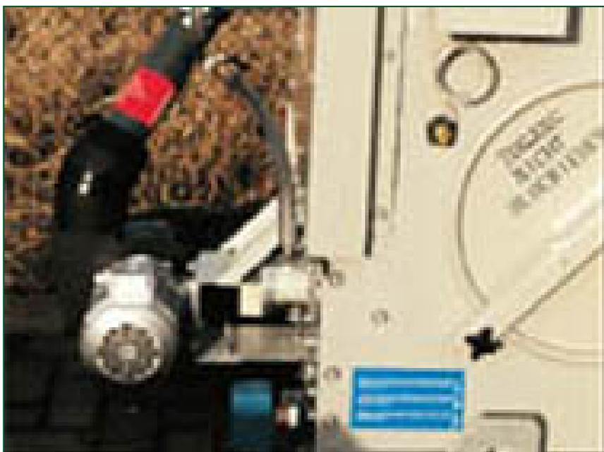
Déplacez la pompe de recirculation de l'eau **du côté connexion** pour les ventilateurs dotés d'atténuateurs acoustiques afin d'améliorer l'accès nécessaire à l'inspection et à l'entretien.
