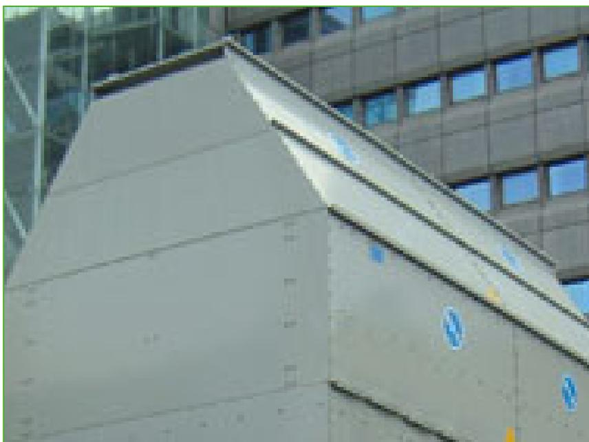
Les hottes de refoulement permettent de se conformer aux prescriptions d'aménagement car elles **surélèvent** le rejet de gaz des installations au-dessus des murs adjacents et augmentent la vitesse de refoulement d'air afin de **réduire le risque de recirculation** dans les espaces confinés.
