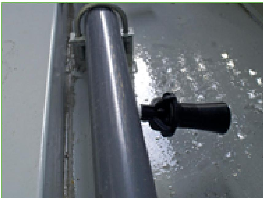
Le système d'injection de bassin **augmente la circulation et l'agitation de l'eau** dans le bassin. Il est conçu pour être utilisé en combinaison avec un [système de filtration](#). Le système d'injection de bassin
