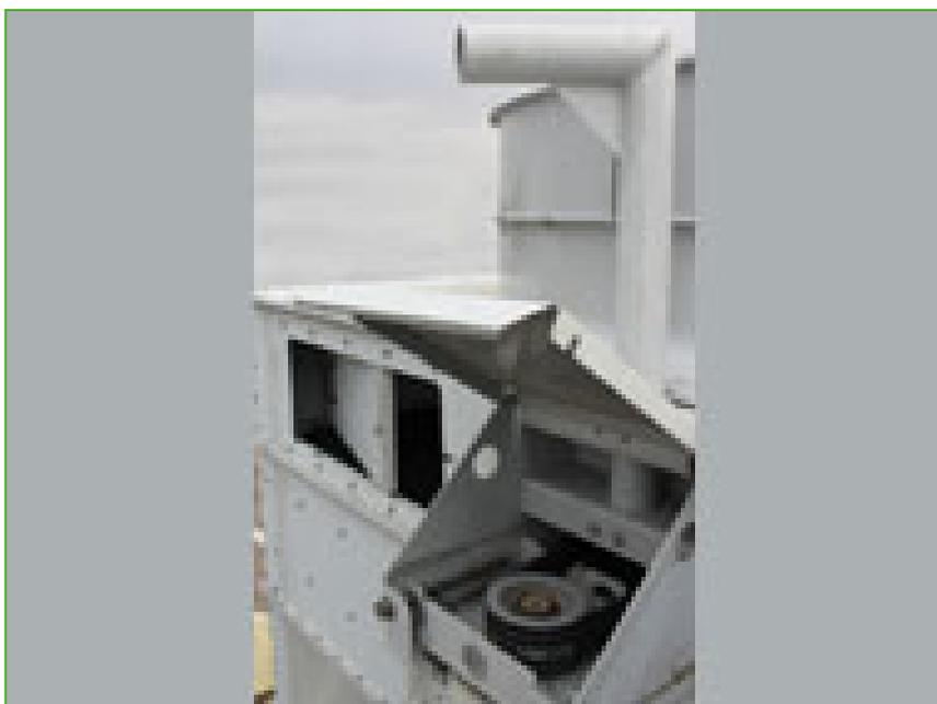
Le dispositif de dépose de moteur facilite grandement **la pose ou la dépose** du moteur de l'installation !
