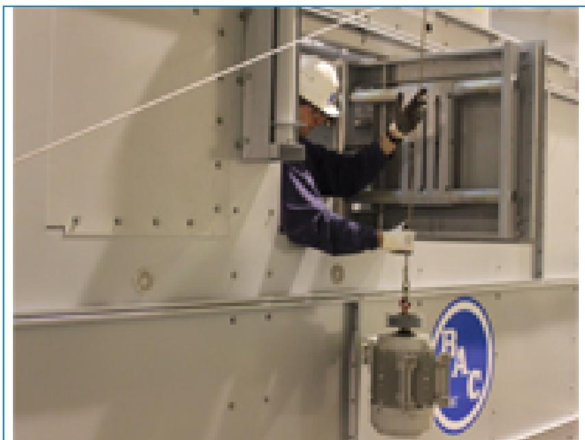
Con el pescante de extracción, el motor **puede bajarse o levantarse fácilmente** hasta la bancada sin necesidad de material adicional pesado de andamiaje.
