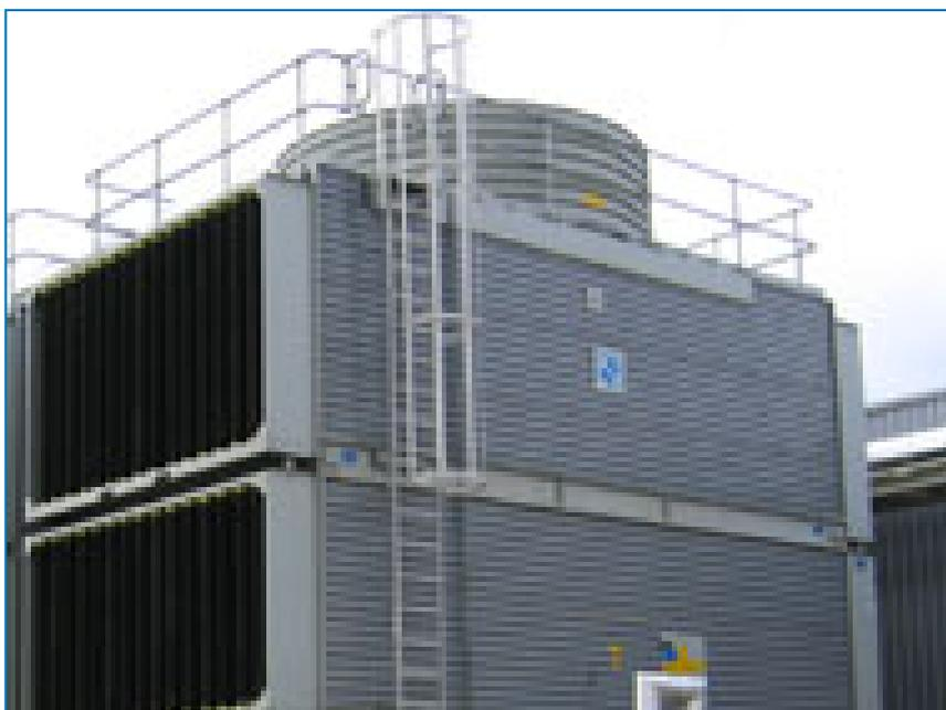
La escalerilla, la jaula de seguridad y la barandilla se instalan **facilitar el acceso a la parte superior de la unidad**, la inspección y el mantenimiento de acuerdo con **las directivas de seguridad de la UE**. Las unidades equipadas con estas opciones cuentan también con [tapas de la bandeja de distribución](#).
