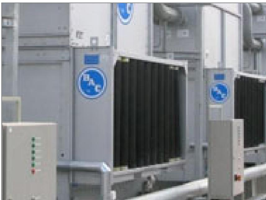
Los condensadores CXVE emplean **ventiladores axiales silenciosos de bajo consumo**, pero puede reducir aún más el sonido ampliando su condensador CXVE con [atenuación sonora](#):
