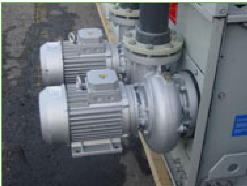
La instalación de una bomba de reserva **garantiza un funcionamiento fiable durante todo el año, ya que se pone** en funcionamiento en caso de fallo.
