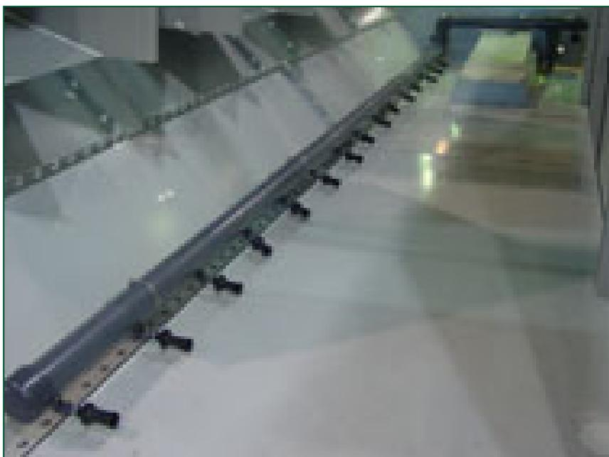
Un sistema de barrido de la balsa **incrementa la circulación y la agitación del agua** en la balsa y se utiliza en combinación con un sistema de [filtración](#). Lleva a cabo las siguientes acciones:
