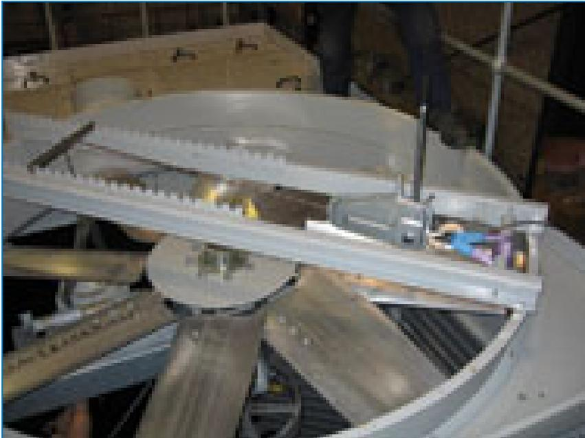
Der Einbau der leichten Ausbau- und Montagevorrichtung hilft Ihnen, **Lüftermotoren oder Getriebe ganz einfach ein- oder auszubauen.**
