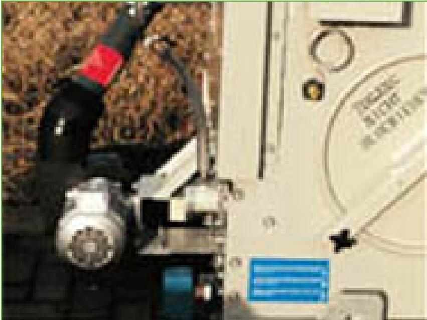
Setzen Sie die Wasserumlaufpumpe **am Anschlussende** bei Lüftern um, die in Schalldämpfern untergebracht sind, um den Inspektions- und Wartungszugang zu verbessern.
